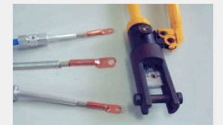
15 使用合适的铜鼻子,将其套入剥好云母带后的线芯
