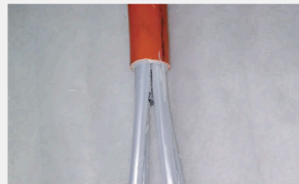
3 根据安装时需要适量剥除本色隔离套
