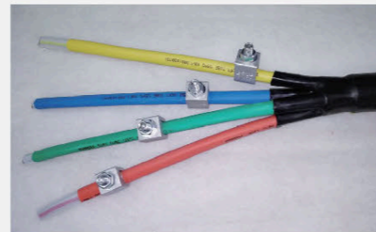
6 把线芯端头铝管剥离20-30mm,在安装好电缆终端连接器
