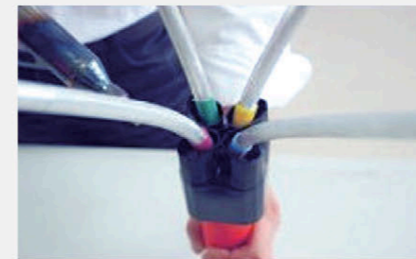
10 将电缆穿进热缩套管,并用电吹风热缩
