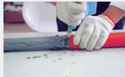
3 用斜口钳剥除耐火层
