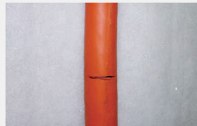
2 量好尺寸，用刀具从护套剥离致铝管层
