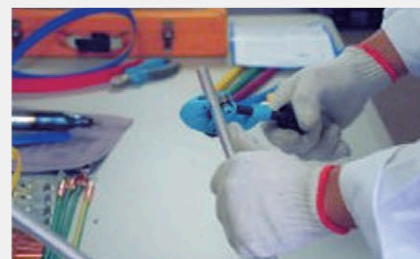
6 使用切管钳(滚刀)将铝管割出痕迹,并且不得损坏云母,以便铝管的剥除
