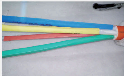
4 把电缆每一根相线套上分色热缩管，并用喷枪热缩
